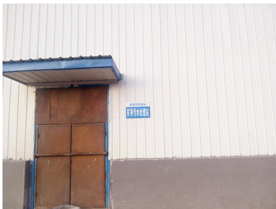
矿井污水处理站
