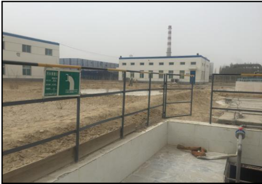
外排工程废水总排口
