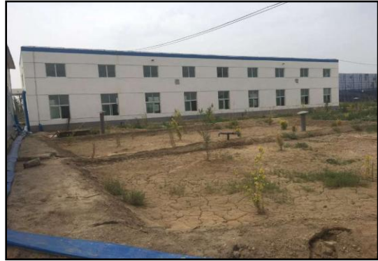
排水泵站周围绿化
