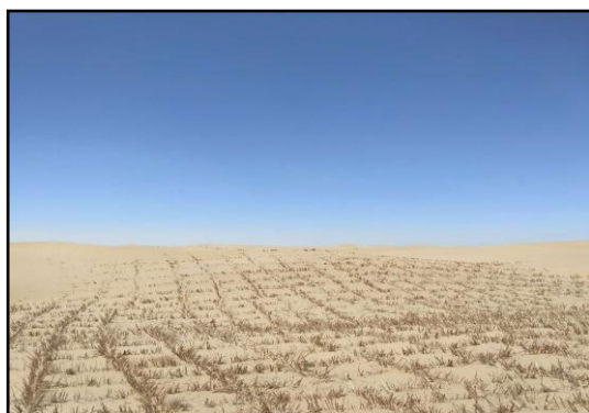
流动沙丘影响地段固沙草方格
