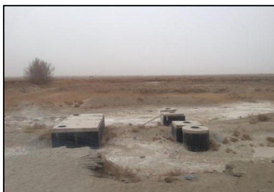
管道沿线检查井
