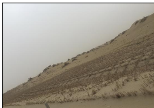
流动沙丘影响地段固沙草方格
